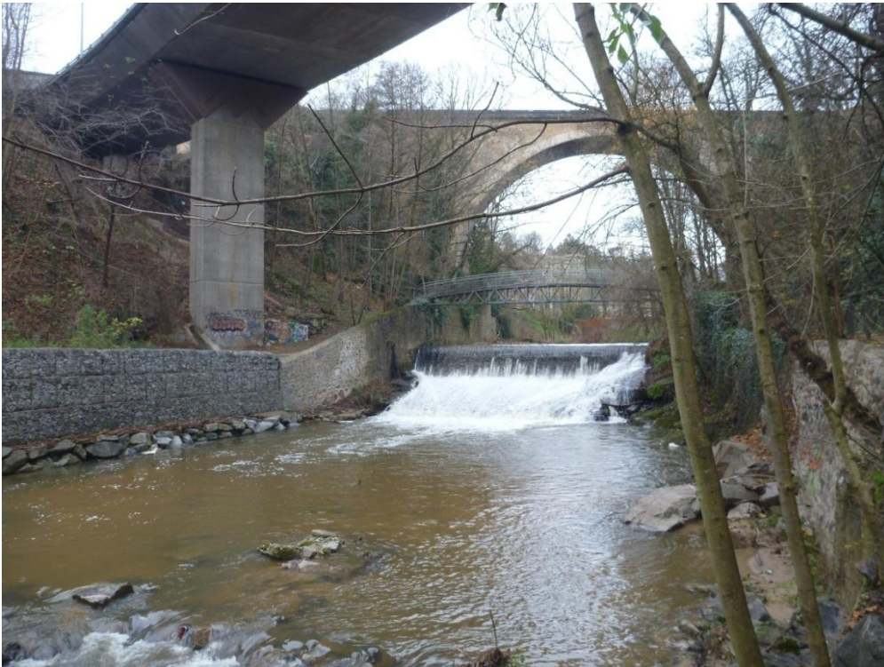
Figure 30 : autre exemple de passage du collecteur sous l'Yzeron.
