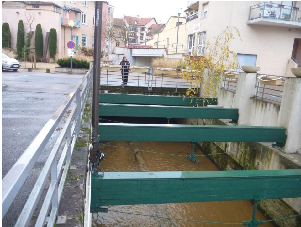
Figure 33 : section canalisée de la Charbonnières.
